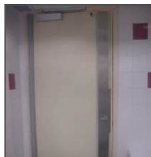
Fig. 4.30 Cam action door closer
