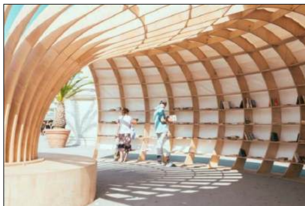
圖3.6 位於保加利亞的一座街頭圖書館，以參數技術設計出輕巧而便於拆卸的木結構。
