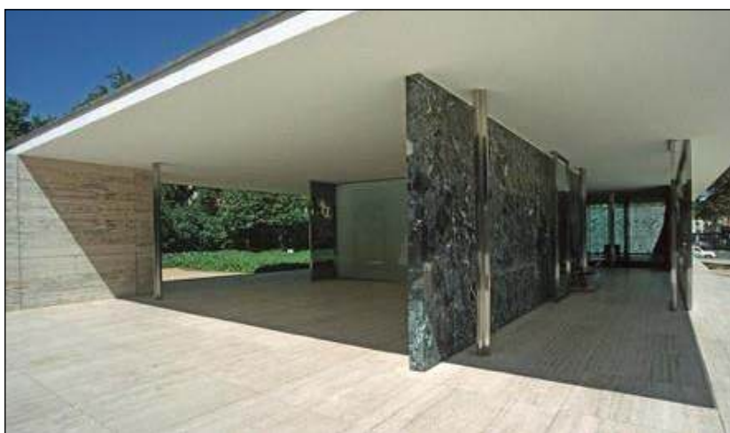
圖2.4 Mies van der Rohe 的巴賽羅拿館使用洞石作結構牆
