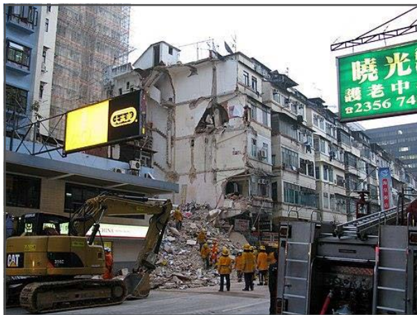
圖2.2 馬頭圍道倒塌的大廈 (圖片來源：Baycrest - 維基百科用戶 - CC-BY-SA-2.5)
