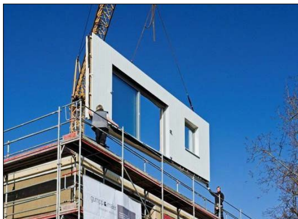
圖 5.1 預製建築材料
