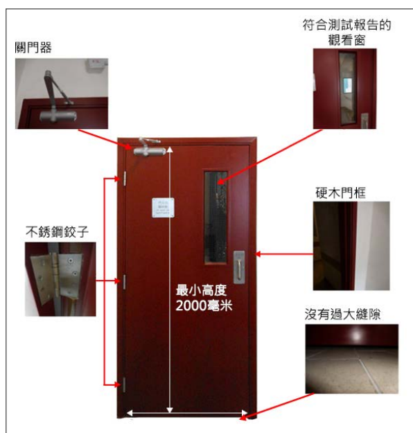
圖3.11 一般的防火門 (圖片來源：屋宇署網頁)
