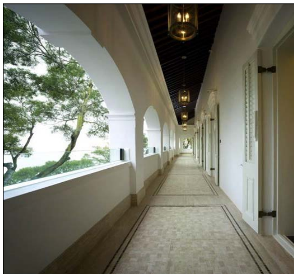
圖 9.4 走廊圍欄的頂部加上透明玻璃
