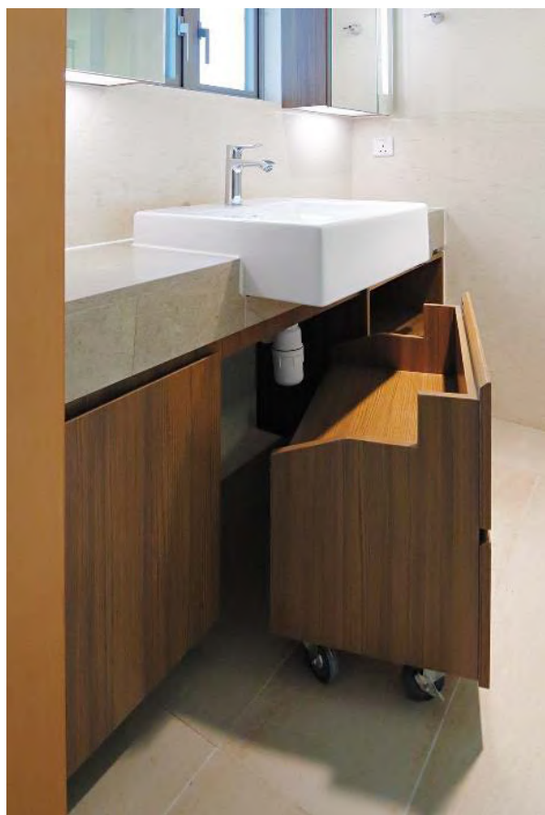
圖 4.56 方便移除的櫃，讓輪椅使用者有空間進入洗手盤位置
